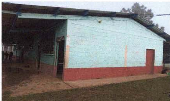
Foto 1: Se observa deterioro en las paredes, desprendimiento de la pintura en las paredes del módulo 1.
