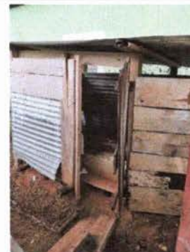
Foto 4: Se observan daños en techo y puertas dañadas en el módulo 8.
