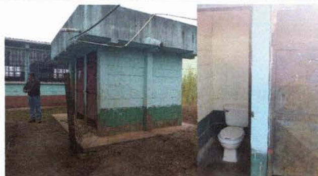
Foto 2: Se observan daños en desprendimiento de la pintura y daños en losa sanitaria del módulo 7
