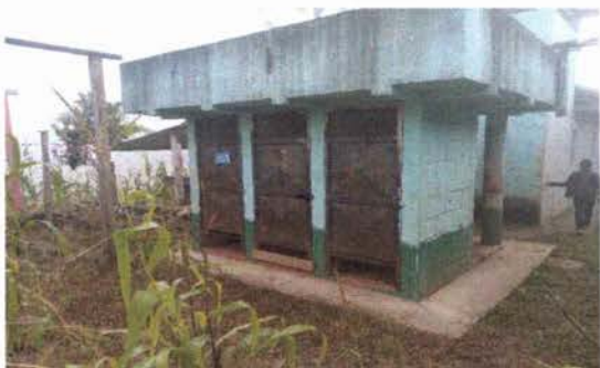
Foto 1: Se observan daños en las puertas y desprendimiento de la pintura en el módulo 7
