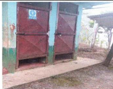
Foto 6: Se observan daños en las puertas y las paredes del módulo 6
