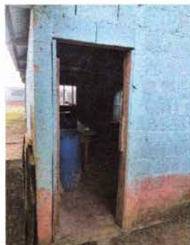
Foto 3: Las puertas se encuentran inservibles y hacen falta los ventanales del módulo 5
