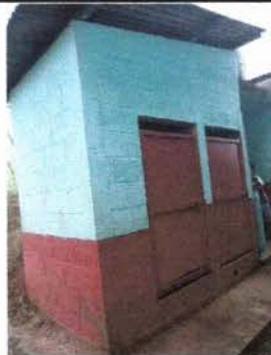
Foto 5: Se observa daños en las puertas y humedad en las paredes por deterioro módulo 6.
