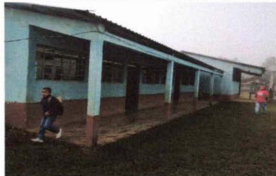
Foto 2: Se observa deterioro de la pintura y humedad en el módulo 4.
