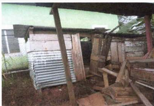
Foto 3: Se observan daños irreversibles en paredes y losa sanitaria en el módulo 8
